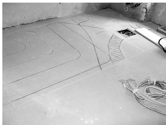
Рис. 5 – Нанесенное на поверхность пола положение труб и кабелей
