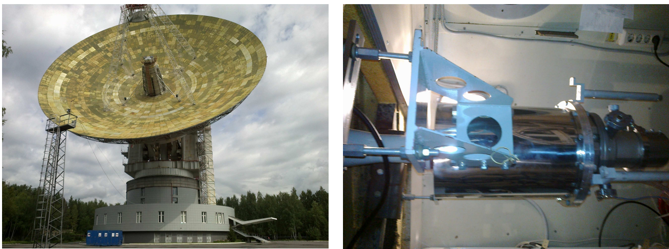
Рис.2. Антенна дальней космической связи ТНА-1500 и КриоМШУ в ее вторичном фокусе.
